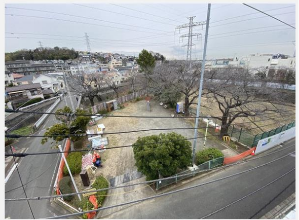
3月5日の建設地
