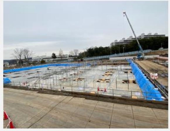
3月5日の建設地
