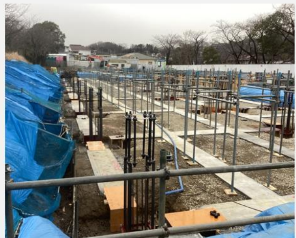
2月29日の建設地
